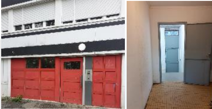
Sécurisation des accès des entrées
