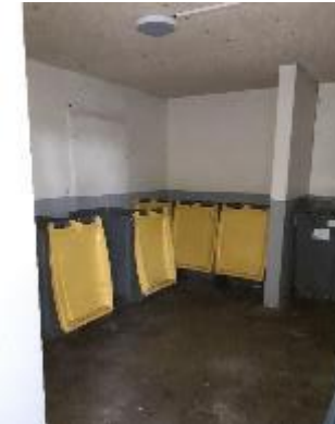
Modifications des locaux poubelles
