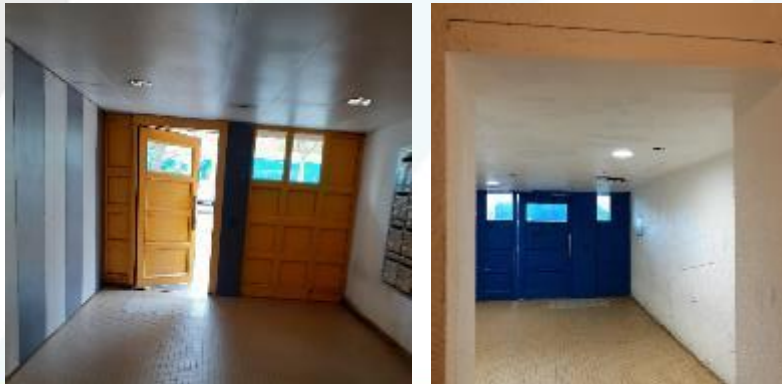
Aménagement des halls d'entrées
